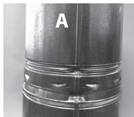
Aligner le joint vertical des deux tuyaux (assurer que la FLÈCHE sur l'étiquette pointe vers le haut ou en s'éloignant de l'appareil).
